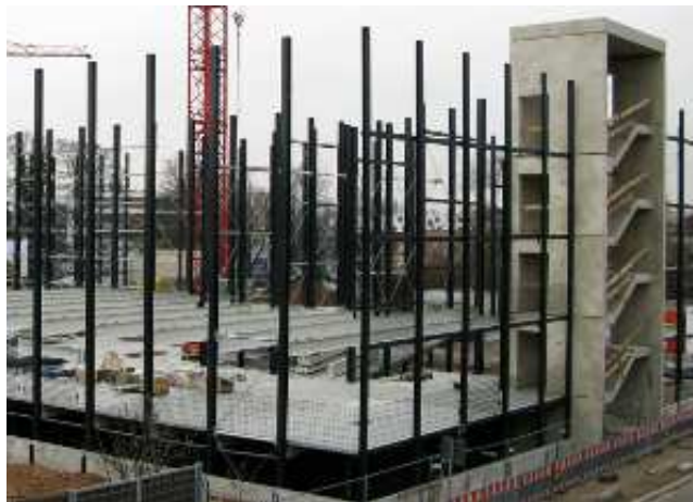
Das Schicksal vor Augen: In diesen Tagen wird das neue Zoo-Parkhaus fertig – sieht so die Zukunft unseres Stellplatzes aus?
